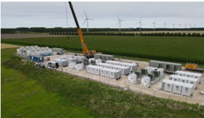
Figuur 5 – Twee grootschalige gridbatterijen van Giga Storage: links de Giga Rhino (2020, 12 MW/7,5 MWh) en rechts de Giga Buffalo (2022, 25 MW/48 MWh)
