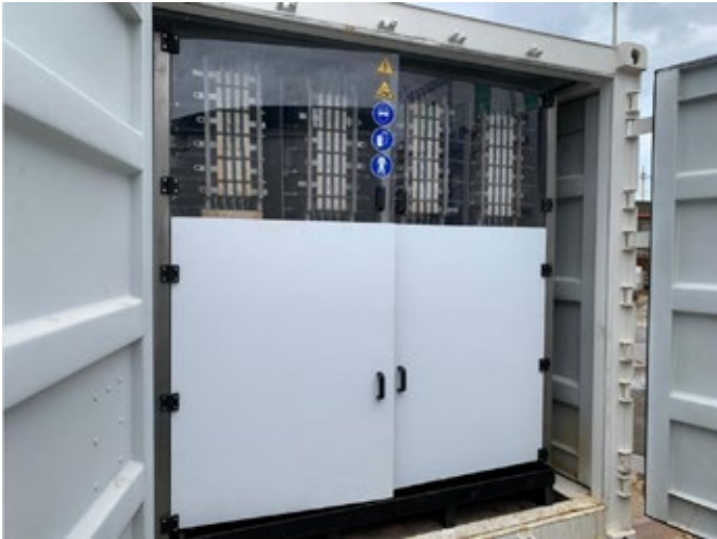
Figuur 7 – Zoutwaterbatterij van AquaBattery met 1 kW/7 kWh 21
