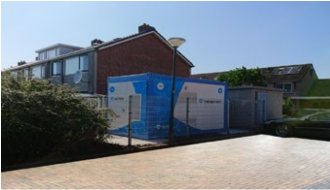
Figuur 4 – Buurtbatterij in Woerden (2018, 200 kWh) 15
