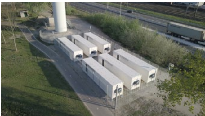
Figuur 3 – Batterijen van totaal 10 MWh bij windpark Hartelkanaal van Greenchoice
